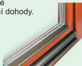
DETAIL MEZISKELNÍHO DISTANČNÍHO RÁMEČKU A OKAPNICE
