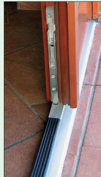
DETAIL AL PRAHU A ZÁSTRČE DVOUKŘÍDLÝCH DVEŘÍ EURO*
